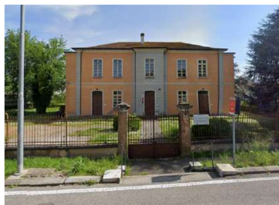
Immagine 4: Immobile oggetto di intervento (Lotto 1)
