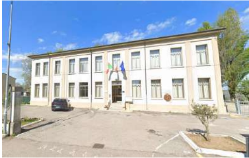
Immagine 28: l'edificio oggetto di intervento
